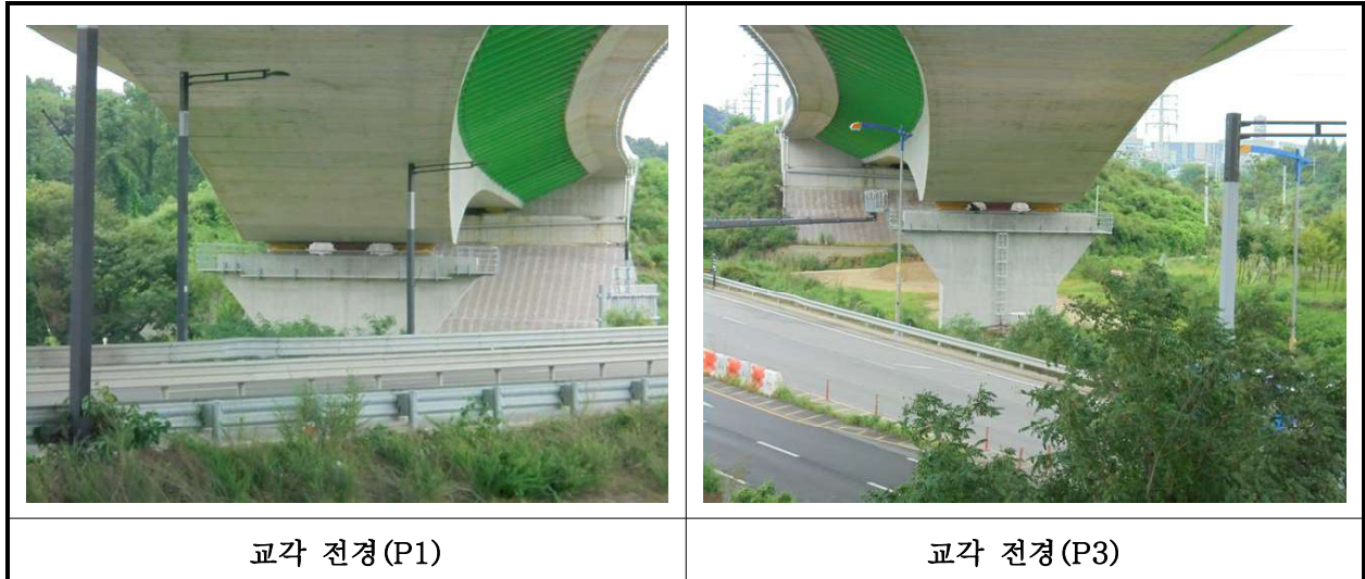
【사진 37.3.10】 교각 전경
