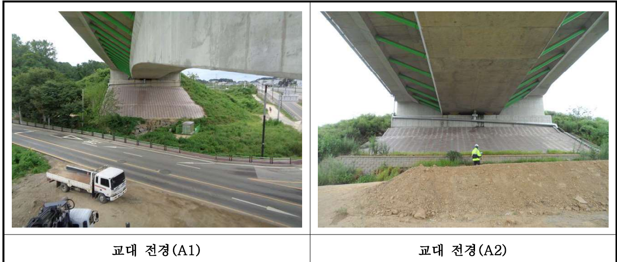
【사진 37.3.8】 교대 전경
