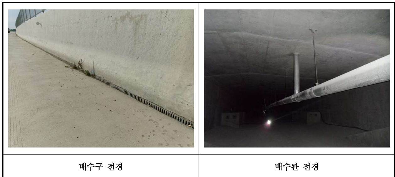
【사진 37.3.21】 배수시설 전경
