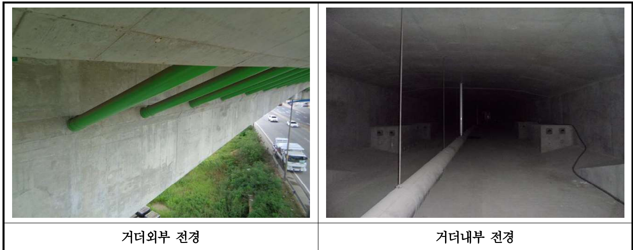
【사진 37.3.4】 거더 전경
