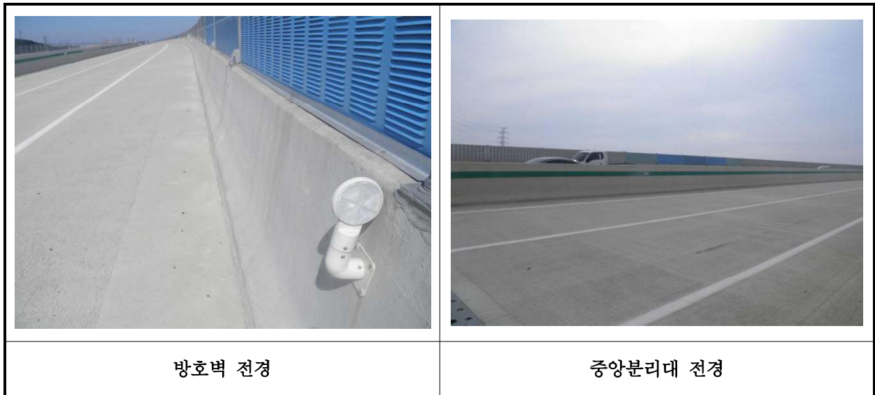
【사진 37.3.23】 방호벽 및 중앙분리대 전경
