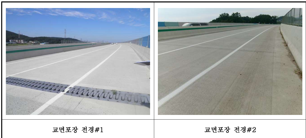
【사진 37.3.19】 교면포장 전경
