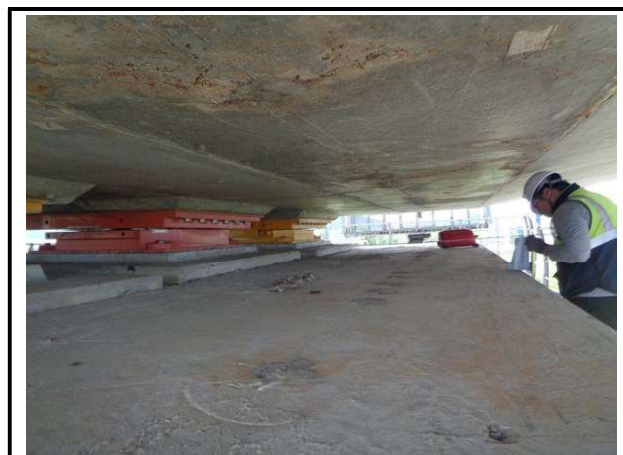
받침장치 연단거리 측정
