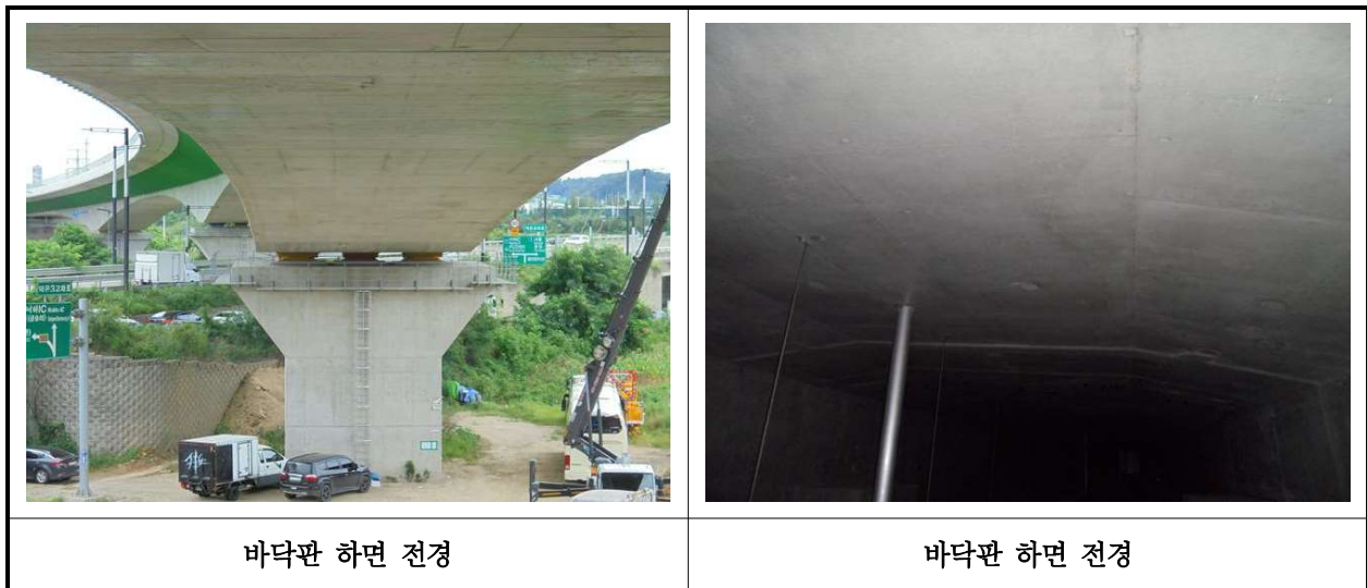
【사진 37.3.2】 바닥판하면 전경
