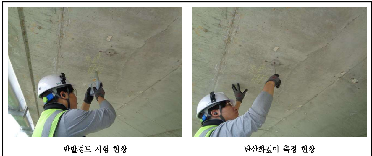
【사진 37.4.1】 콘크리트 내구성조사 현황
