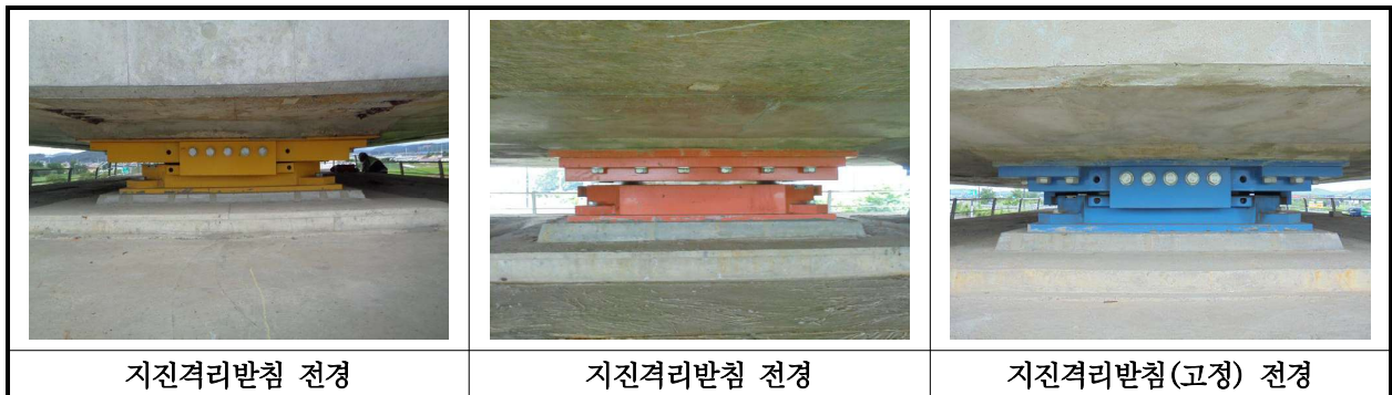
【사진 37.3.12】 교량받침 전경
